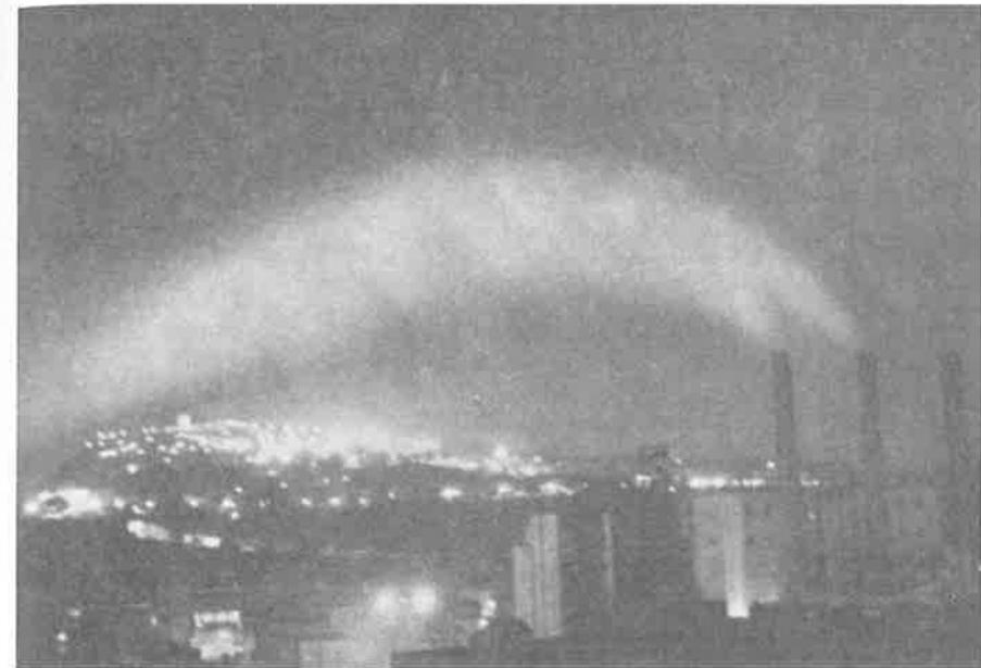
**Figura 3.3** A) Formación de una cúpula de aire contaminado encima de una ciudad. B) Fotografía de la pluma de humo emitida por las chimeneas de la central térmica del Paralelo, cuando estaba en funcionamiento: el humo cae de nuevo al suelo debido a la inversión térmica. (Foto: Juan B. López Cayetano, del 24-9-1969.)
